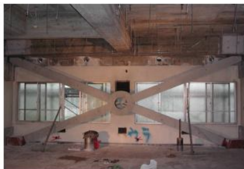
نمونه‌ای از مهاربند بتنی پیش‌تیبده و پیش‌ساخته
