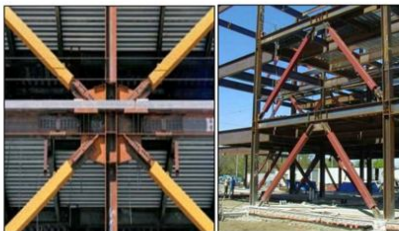
نمونه هایی از مهاربند ضد کمانش BRBF
